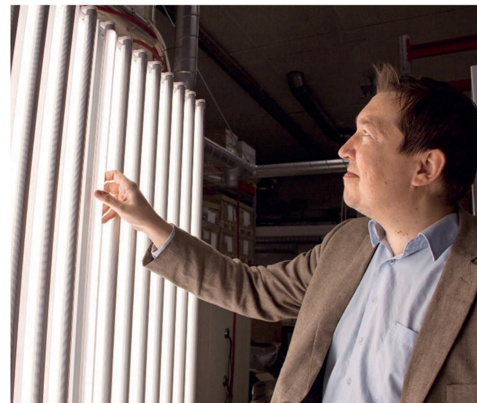
«Además de tener un elevado consumo energético, el problema con los antiguos tubos fluorescentes es la tendencia de los bastidores a deteriorarse debido al calor, la radiación de los rayos ultravioletas y la necesidad frecuente de cambiarlos», señala Markku Laatikainen, director general de Valtavallo.
